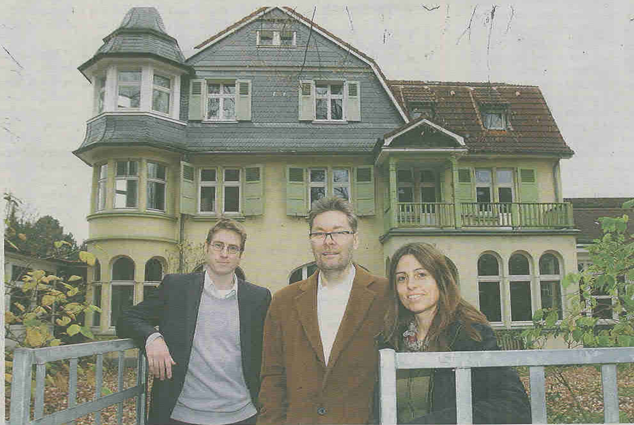
André Kleinpoppen (M.) mit Katja Weiner (Bauleitung) und Christian Bendig (Vertrieb) vor dem Gebäude aus dem Jahr 1909. Foto: Christian Beier
